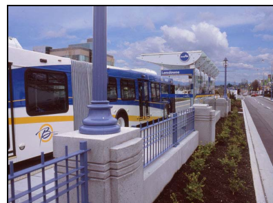
(d) Median Busway (Vancouver)
